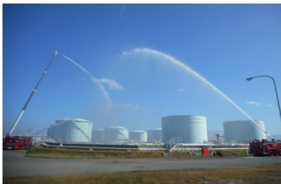
関西国際空港 給油センター
