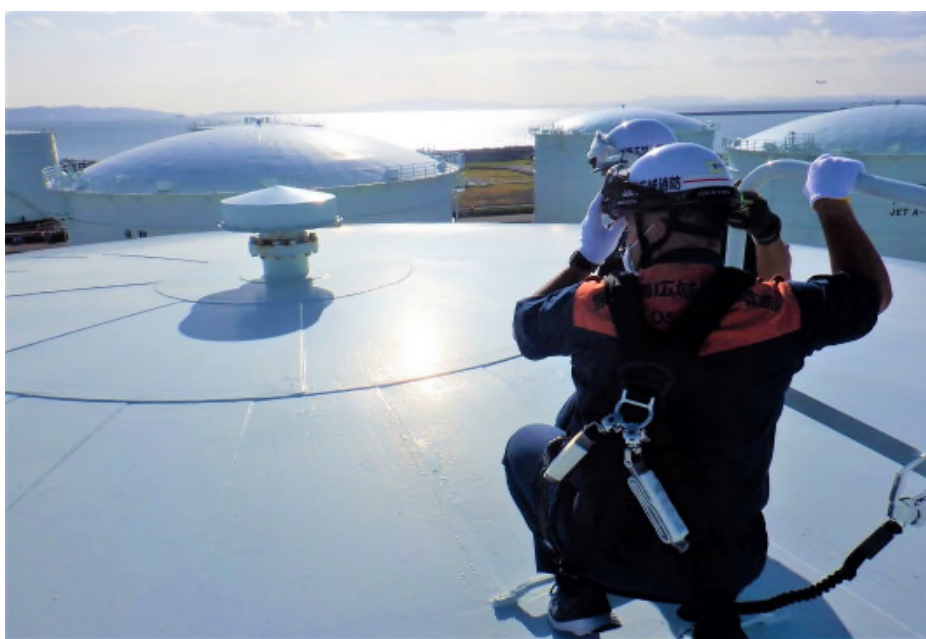
関西国際空港の特定屋外貯蔵タンク検査の状況
