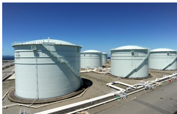
関西国際空港給油センター
