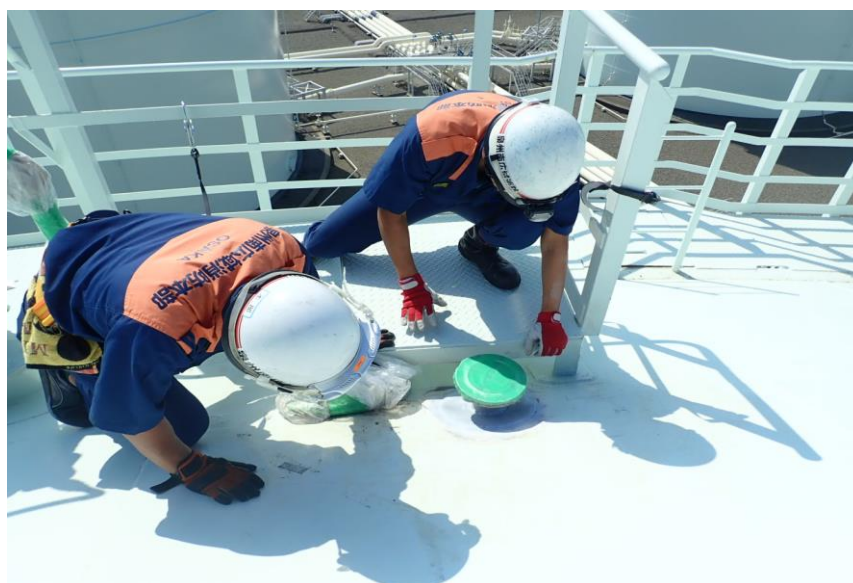
関西国際空港の特定屋外タンク 検査の状況
