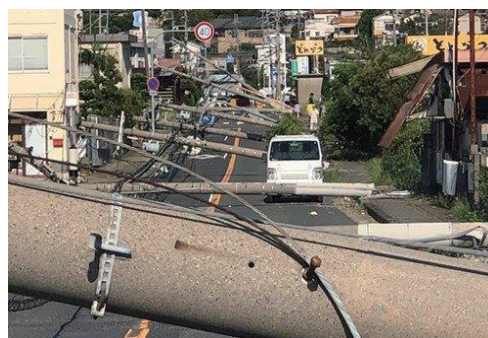
【平成 30 年台風 21 号の被害状況】
