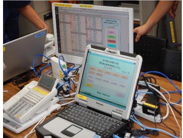
非常時対応部分訓練を実施 (令和3年9月24日)
